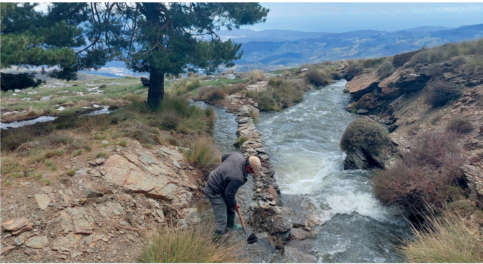
Acequero derivando el agua de una acequia de careo para su siembra o recarga de acuíferos. Mecina Bombarón, Sierra Nevada, Granada.
